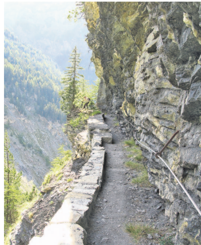
In der Natur. Die Suone von Ayent wurde vor 1448 errichtet.
