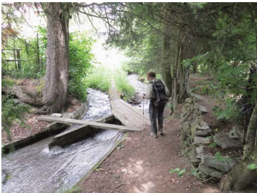
Bitaille et système de répartition d'eau. N. HAGER
