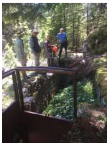
Les écluse de la Prise d'eau du Bisse d'Ayent dans la Lienne
