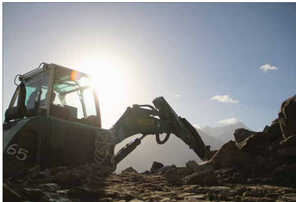
Le téléphérique de liaison entre Grimentz et Zinal est actuellement en construction. Ce chantier est à la base de la fusion des deux sociétés de remontées mécaniques, entérinée le 15 septembre prochain. SIERRE-ANNIVIERS
