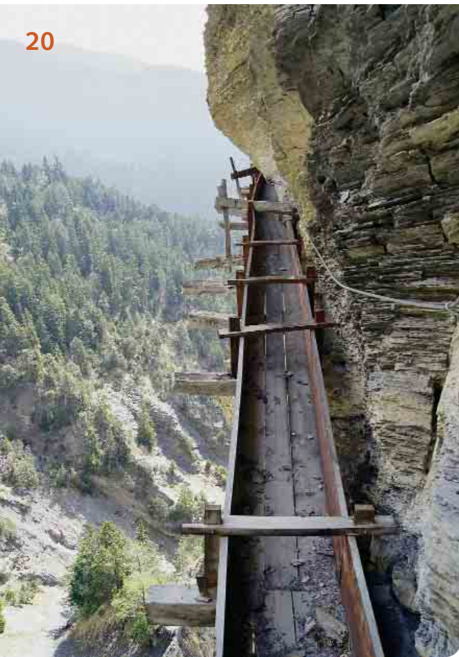
Les anciens chéneaux du bisse d'Ayent. Le chemin passe dans un tunnel.
