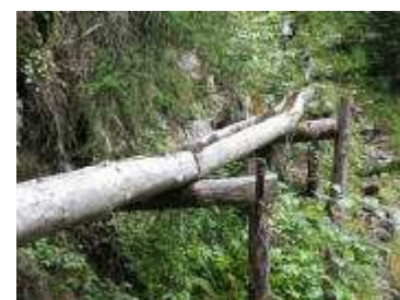
Dans les endroits rocheux ou sur des sols très perméables, les auals sont souvent faits de troncs d’arolles évidés
